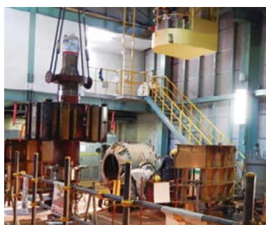
既設機器取外
