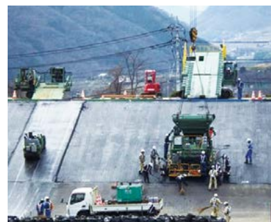
アスファルト表面施工状況
