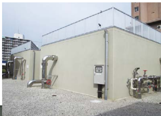
改修後の貯湯槽
