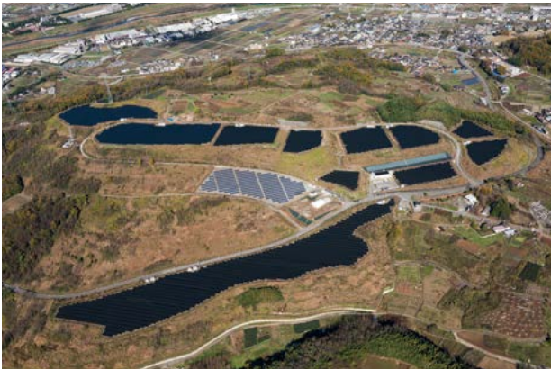
米倉山太陽光発電所全景
