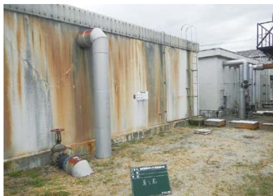
改修前の貯湯槽
