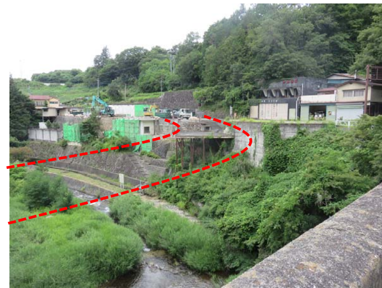
建物撤去時の状況
