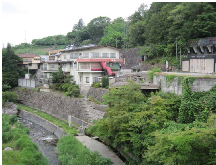
建物撤去前の状況
