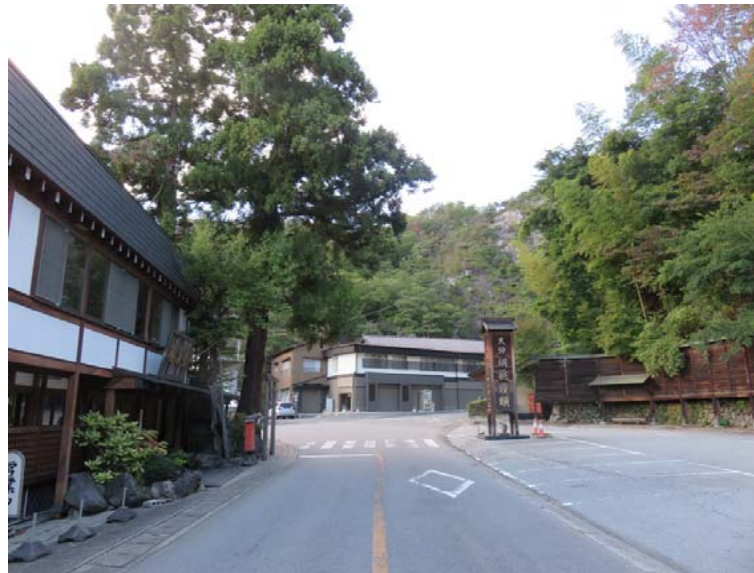
建物撤去前の状況
