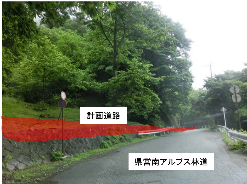
③芦安側 県営南アルプス林道付近
