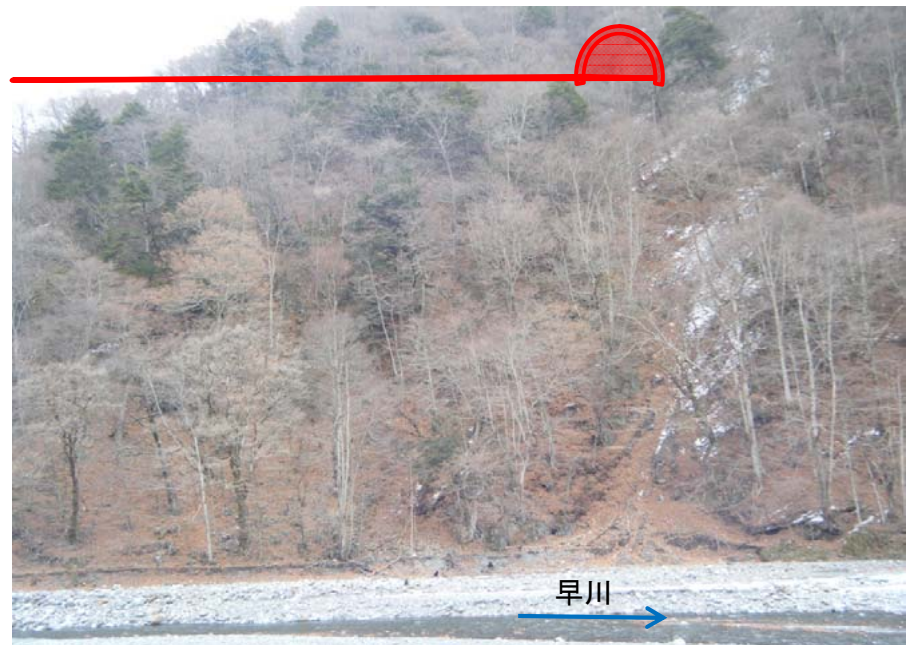
②早川側 早川～トンネル坑口付近
