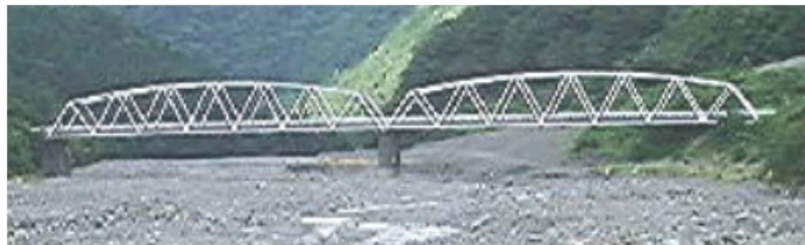
③奈良田橋
