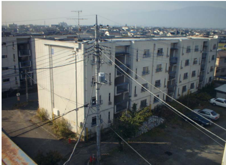
解体10号館 北側外観
