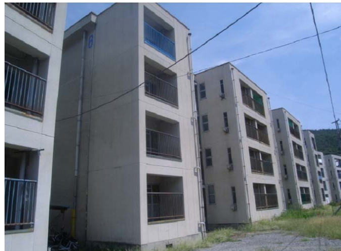
解体6号館 南側外観
