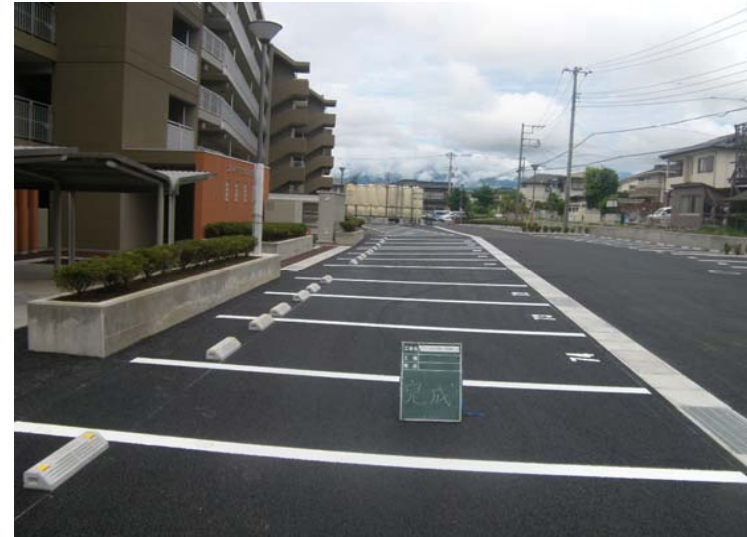
駐車場（透水性舗装）
