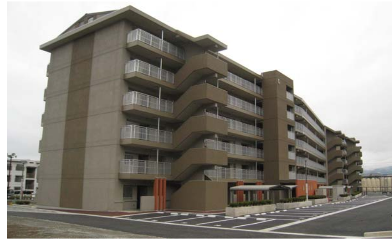
新C号棟 北側外観
