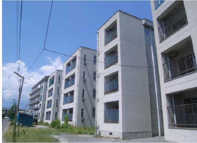
解体9号館 南側外観
