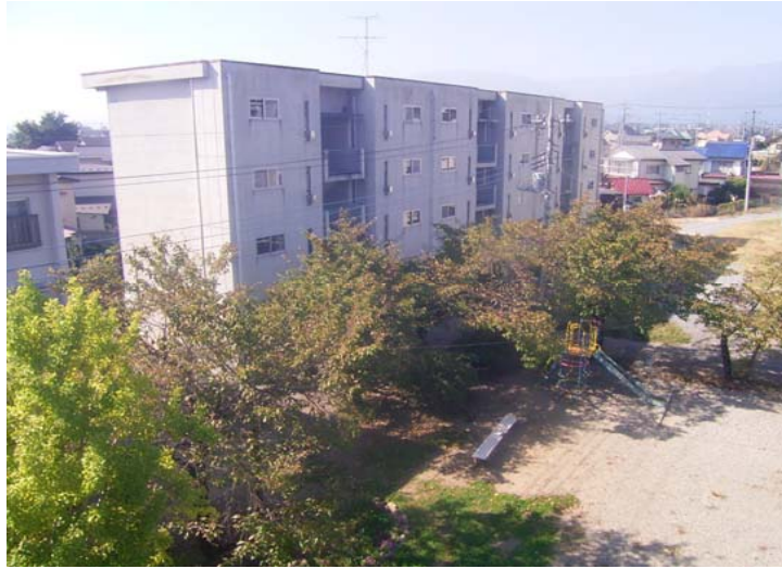
解体22号館 北側外観
