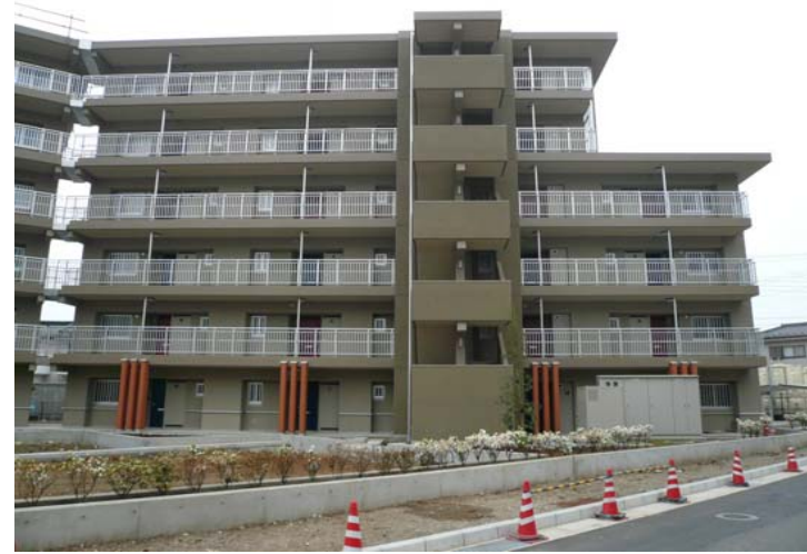
新A号棟 北側外観
