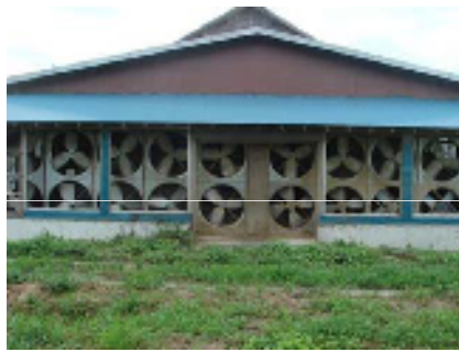
牛舎壁面の換気扇
