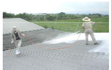
石灰の吹きつけ
