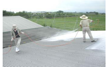
石灰の吹きつけ
