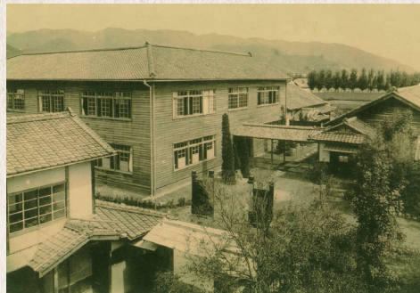
甲府市湯田町に建設された山梨裁縫学校 写真提供 伊藤学園甲斐清和高等学校
