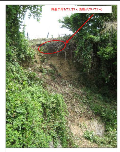
土砂崩落により既設農道下がオーバーハングしている状況
