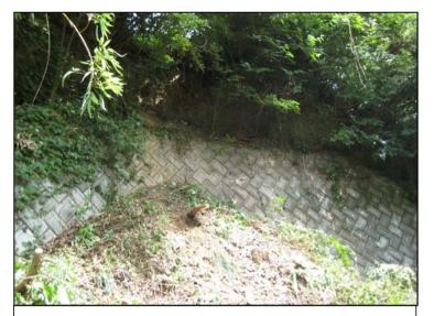
毎年の豪雨よる法面の崩落により、法面直下の水路に 土砂が堆積している状況
