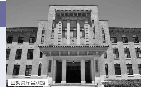
山梨県庁舎別館
