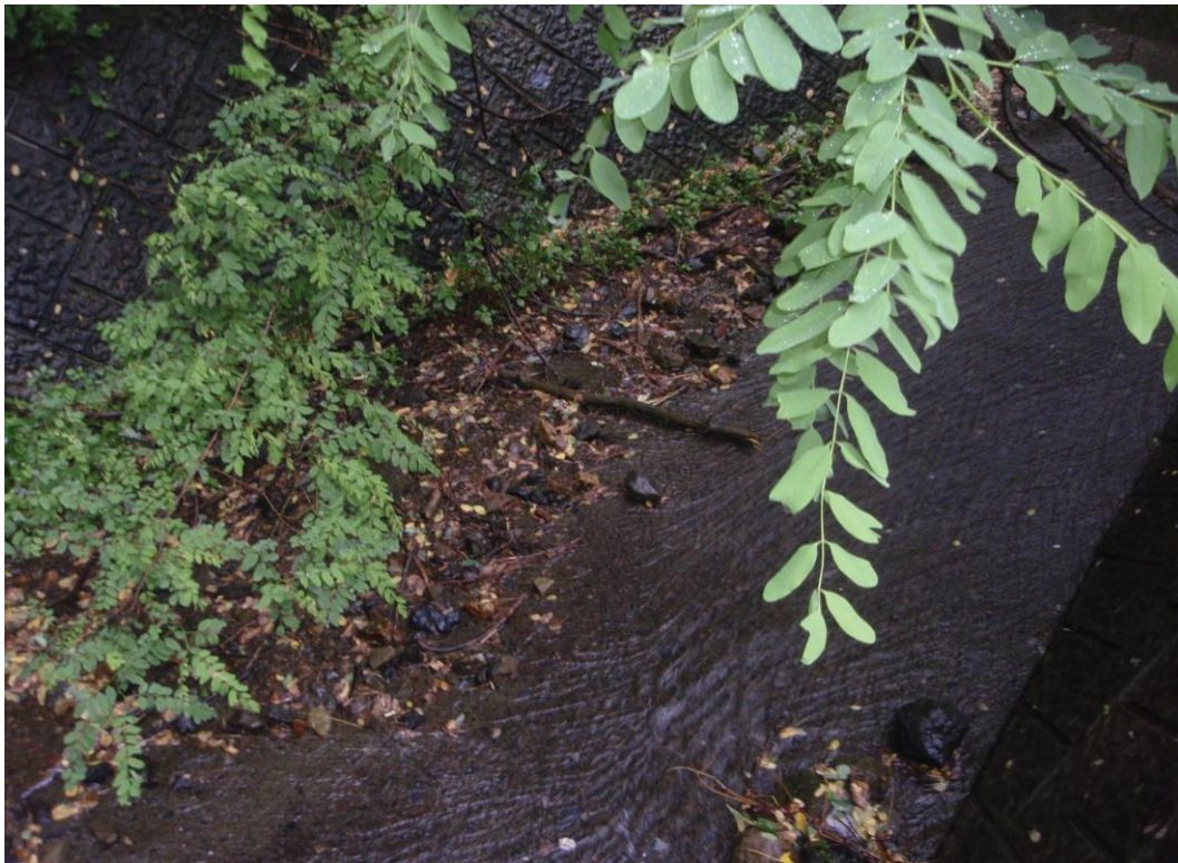
写真1-4-2 A沢三面張水路下流
