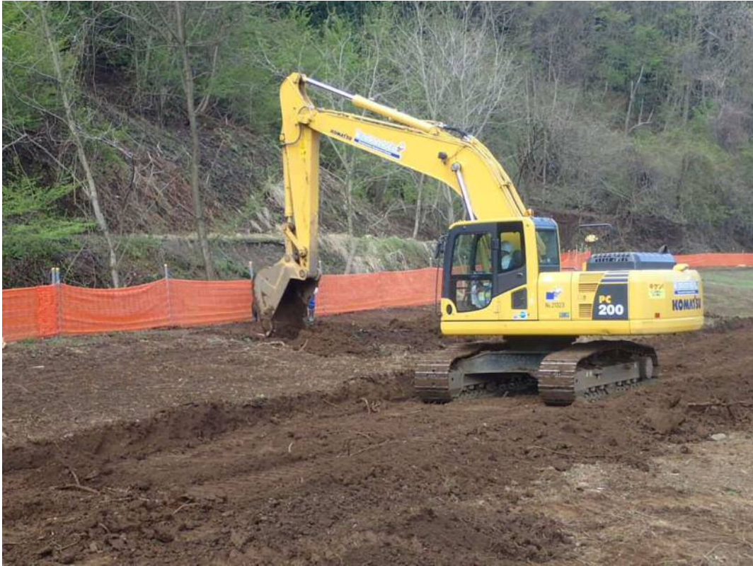
仮設水路の掘削写真（工事区域南側斜面）
