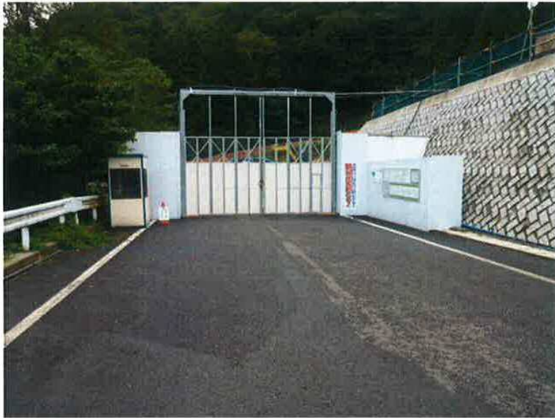
仮設工事 仮囲い 北面ゲート フラットパネル H3000 ゲート H3000
