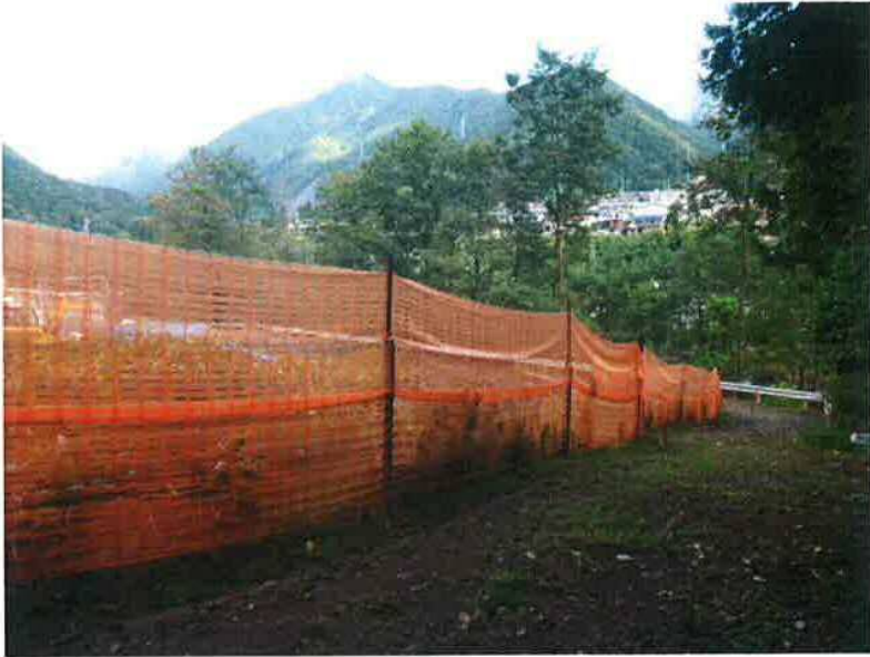
仮設工事 仮囲い 東面 立入禁止柵 H1000
