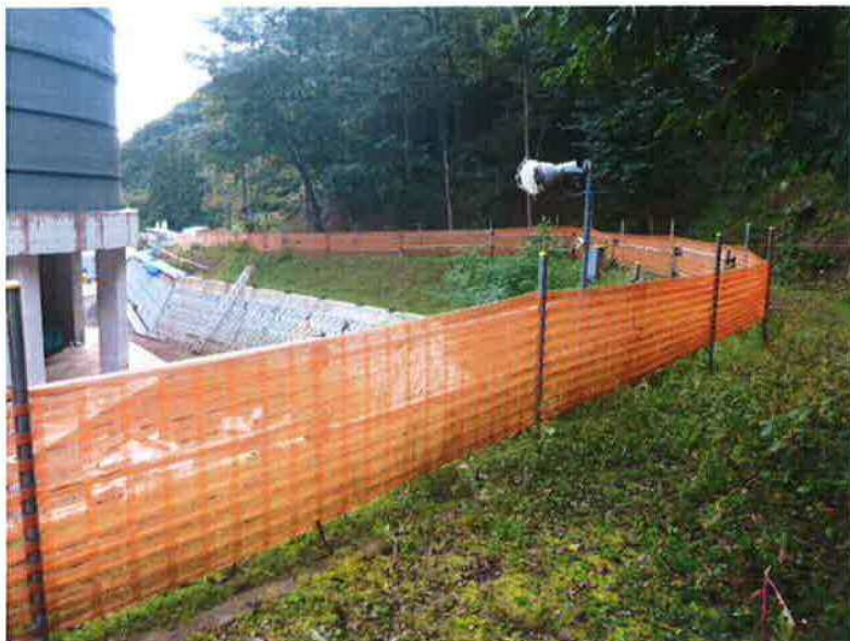
仮設工事 仮囲い 南面 立入禁止柵 H1000
