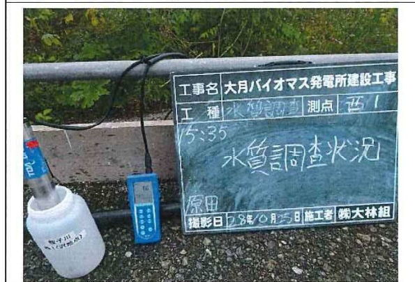
10/25水質調査状況(西1)
