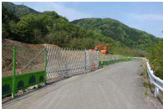
現場出入口ゲート
