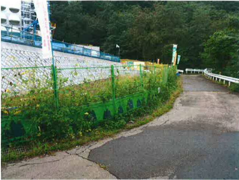
仮設工事 仮囲い 北面 ガードフェンス H1800
