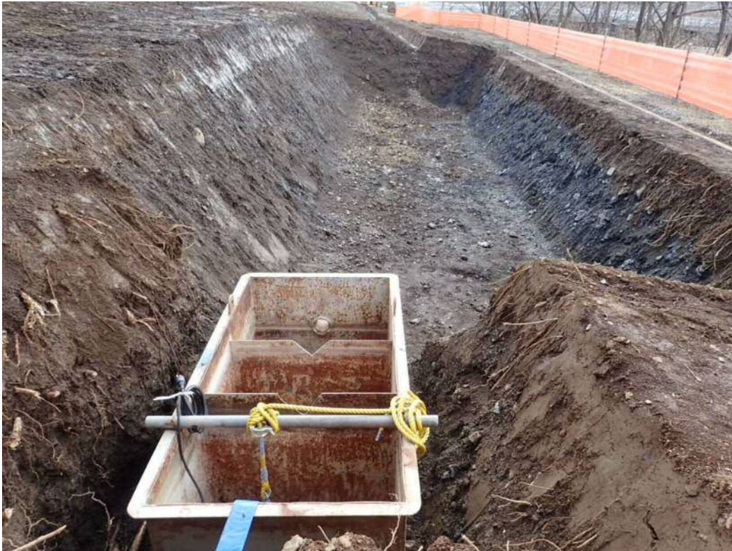
手前の窪地が仮設沈砂池と奥の溝が仮設水路の写真
