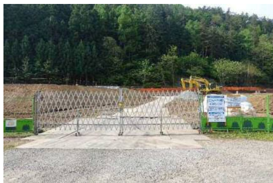
現場出入口ゲート
