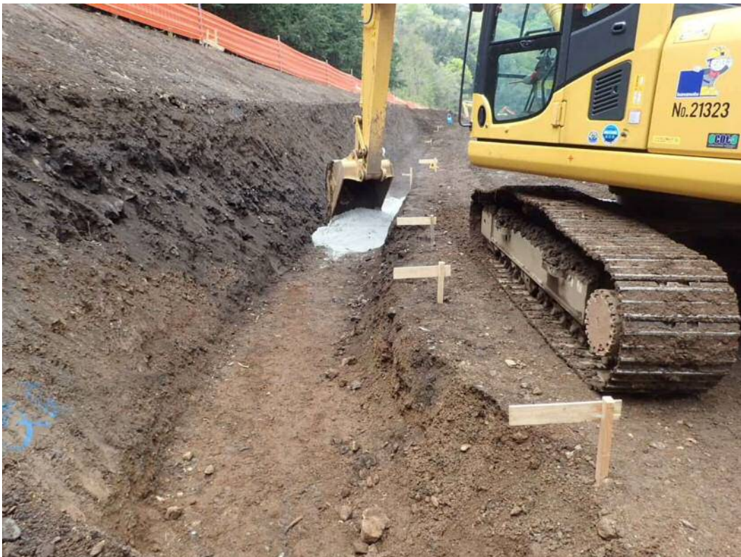
仮設水路を掘削する写真（工事区域南側斜面）
