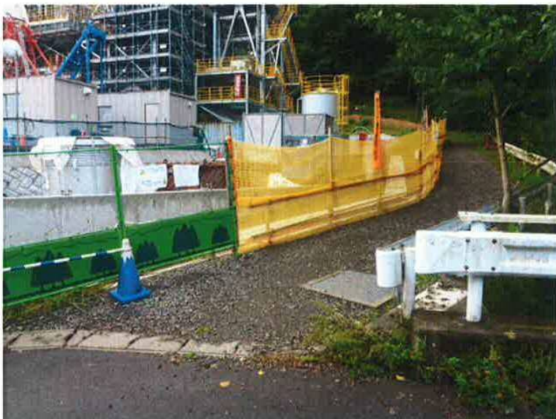
仮設工事 仮囲い 西面 立入禁止柵 H1000
