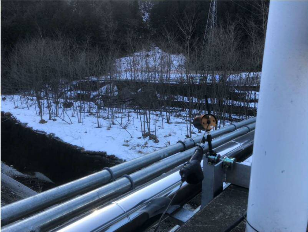
工事区域に渡る橋の設置した監視カメラの写真
