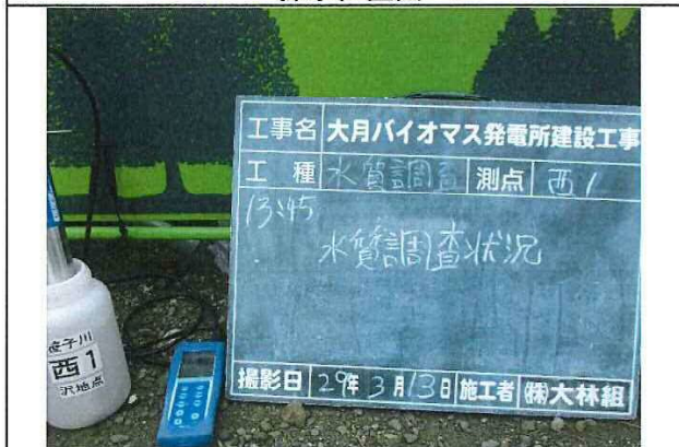
3/13 水質調査状況(西1)
