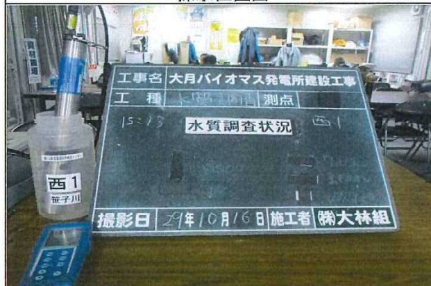
10/16 水質調査状況(西1)
