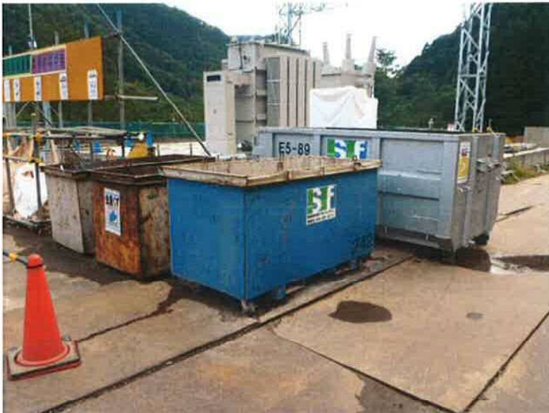
仮設工事 産廃分別状況 スクラップ・木屑・CONガラ
