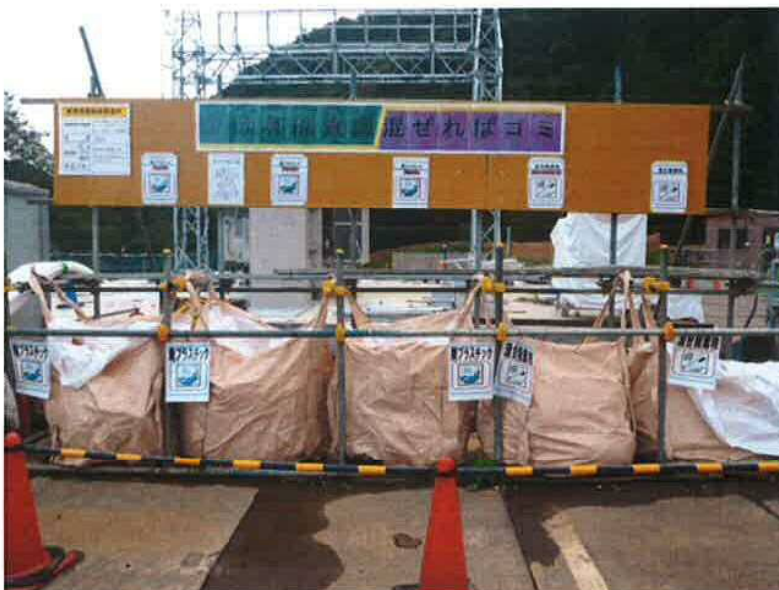
仮設工事 産廃分別状況 混合・廃プラスチック
