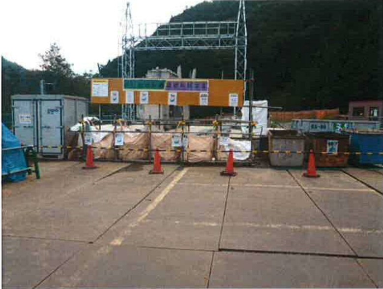
仮設工事 産廃分別状況 全景
