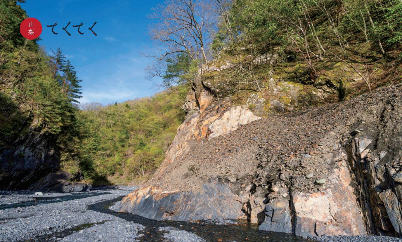
雨畑川上流にある坑道の入口付近
