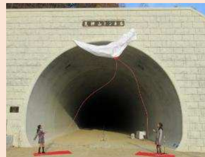
▲荒神山トンネル
