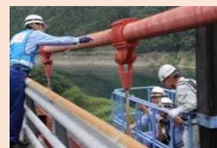
▲国道メンテナンス
