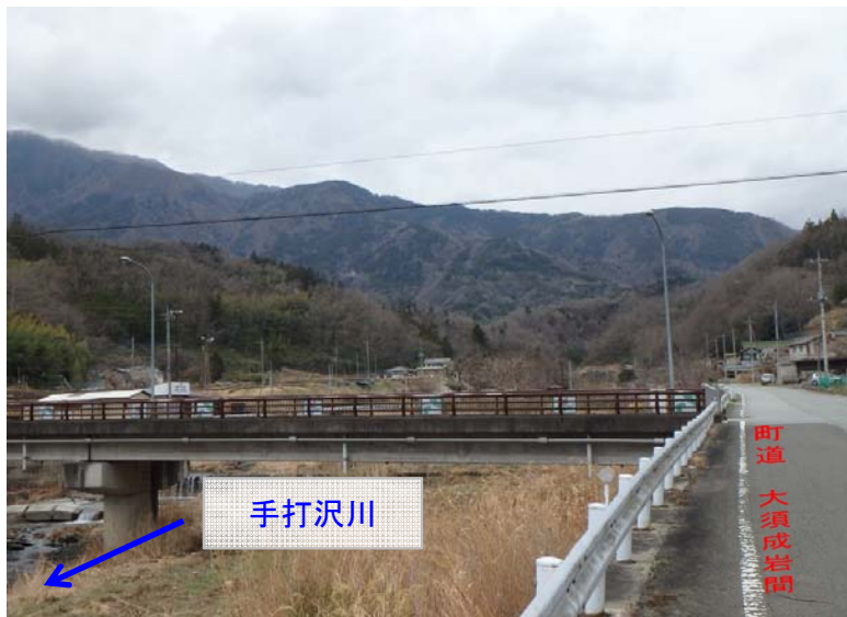
下流保全対象(下流から上流)
