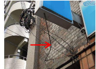
振れ止め棒等が変形していないか。
