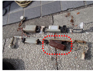
変圧器（トランス）や配線が劣化、破損していないか。
