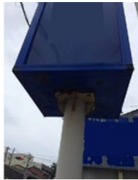
支柱と広告板の接合部
