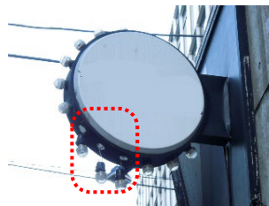
照明装置の取付部が破損等していないか。
