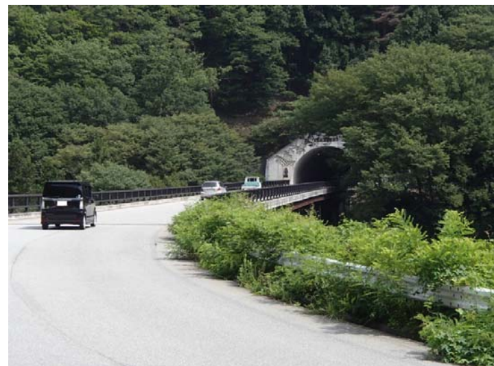
【写真④】 既整備箇所の状況 (大渡バイパス (新紅葉橋・鳥居坂トンネル))
