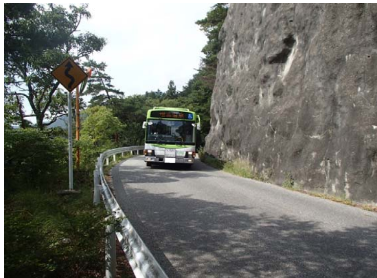
【写真③】 現道の状況 (幅員狭小、線形・見通し不良)
