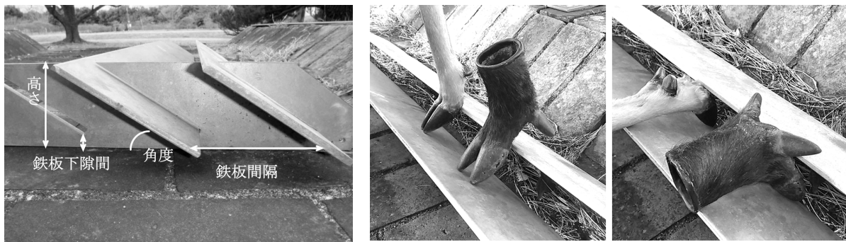
図3 グレーチングの原理。
