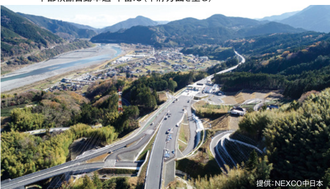
中部横断自動車道 富沢IC (静岡方面を望む)
