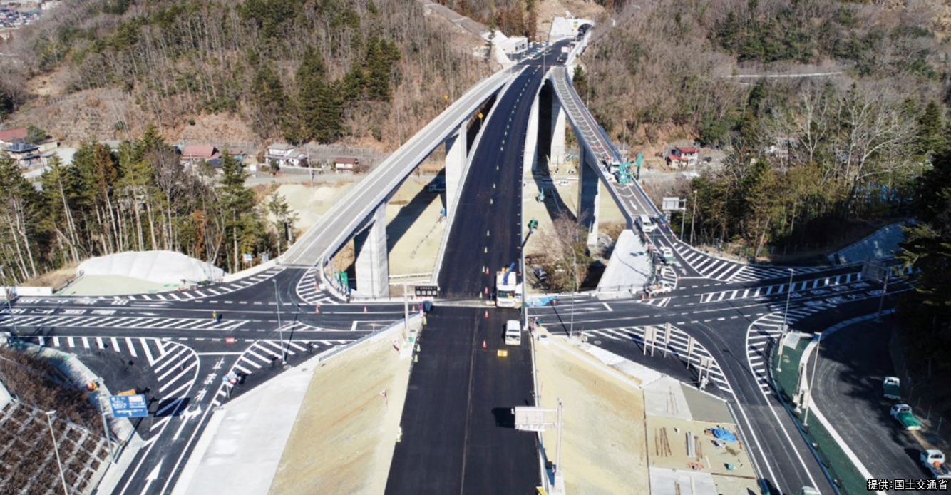
中部横断自動車道 中富IC (甲府方面を望む)
