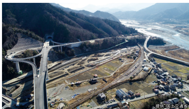
中部横断自動車道 下部温泉早川IC (静岡方面を望む)
