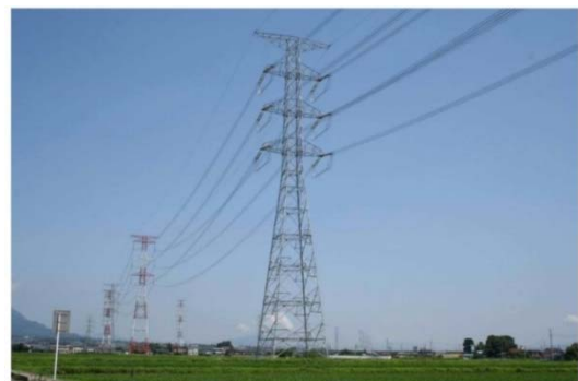
送電線路の完成例
