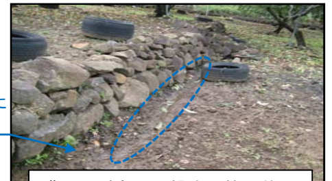
農地の端部での排水対策の状況
