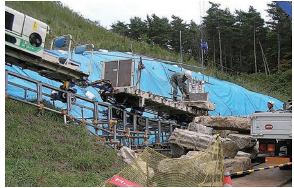
資材等運搬 (モノレール)
