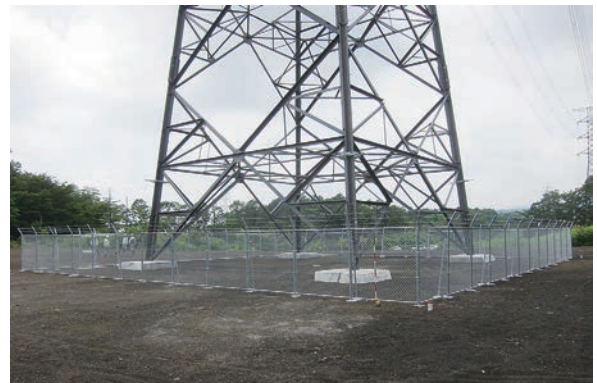
鉄塔フェンス
