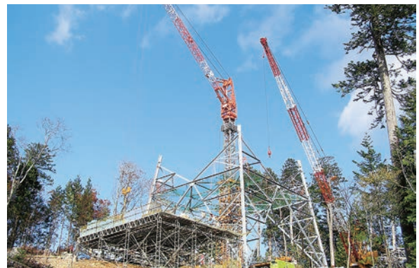
鉄塔組立 (クライミングクレーン)
