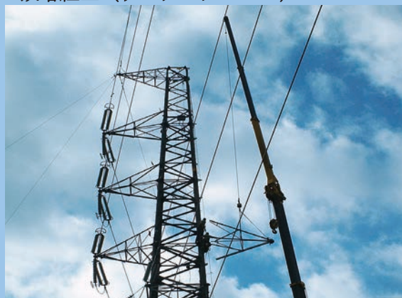
鉄塔組立 (ラフタークレーン)
