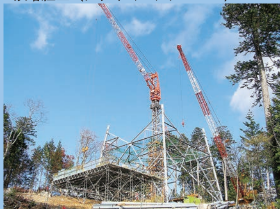
鉄塔組立 (クライミングクレーン)
