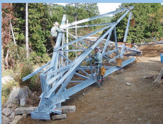
図1.4-8 工事の流れ（基礎工事、鉄塔組立工事）
