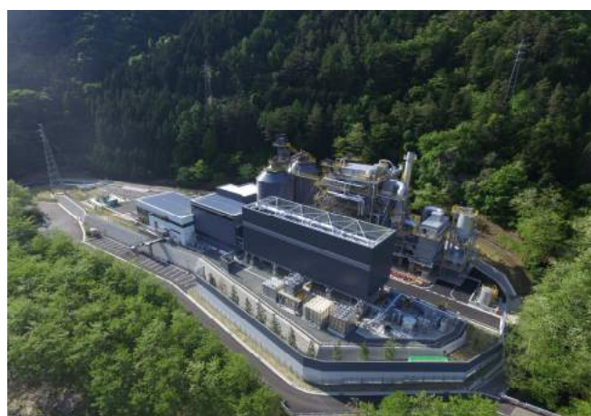
木質バイオマス発電所（大月市内）
