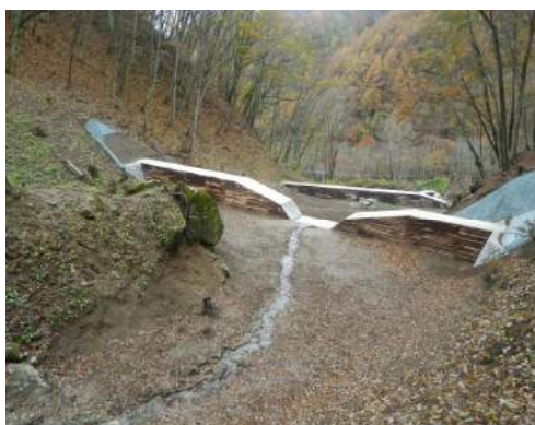
治山ダムの設置
