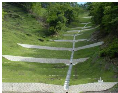
山腹工による崩壊地の復旧状況
