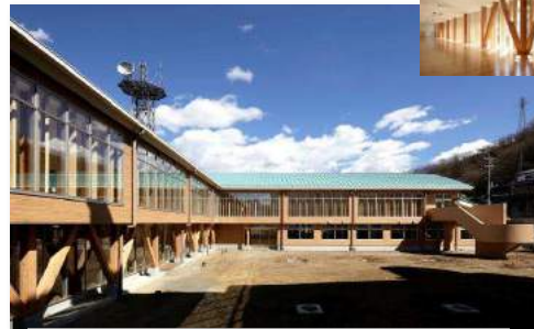
H28 大月短期大学校舎 木材量 600 m 3 （県産材 557 m 3 ）
