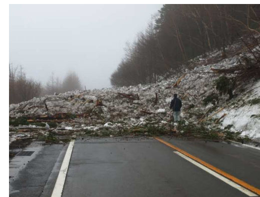
被災状況（H25/04/08 苔桃橋）
