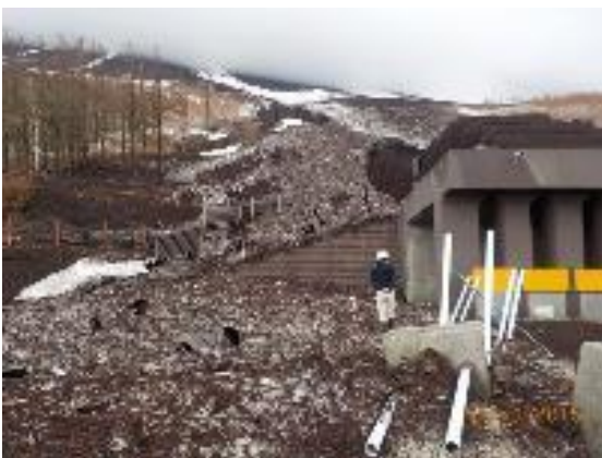
スラッシュ雪崩による被災例
