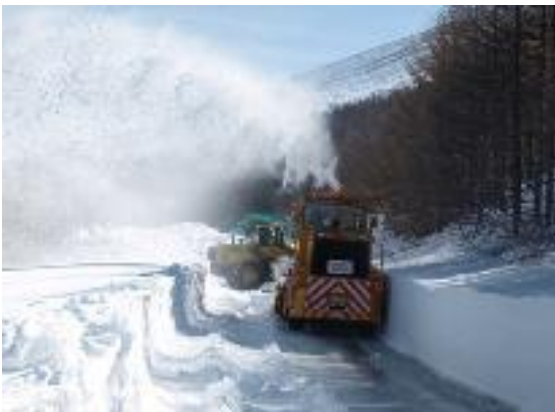
除雪の様子(五合目付近)
