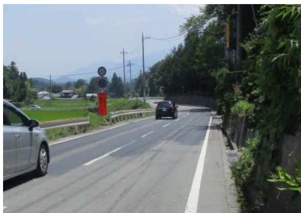
④ ため池直下には県道があり交通量も多い。
