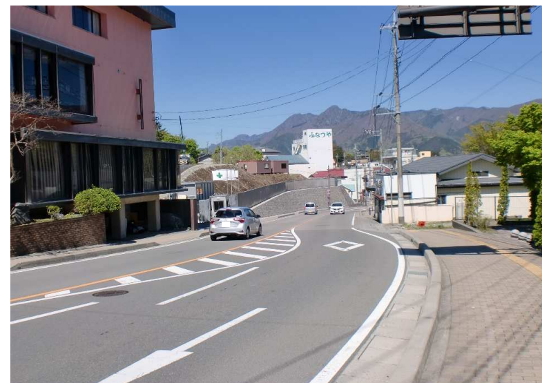
④整備後（円滑な交通が確保された）船津交差点
