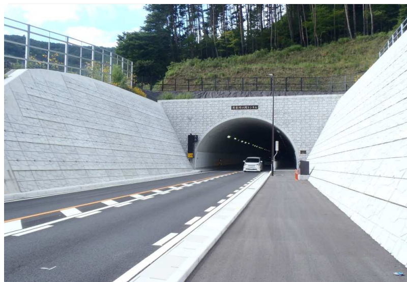
③ 整備後（バイパス完成状況）富士吉田市側坑口
