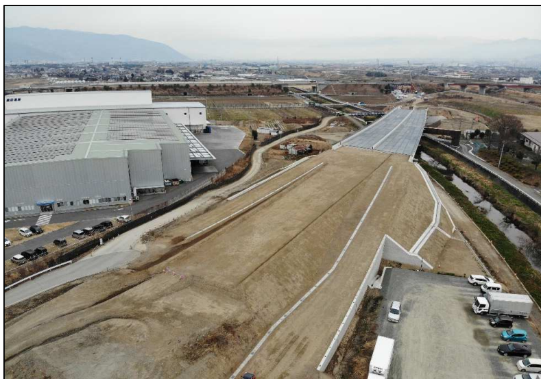
【 上空からドローンにて現場を撮影 】
