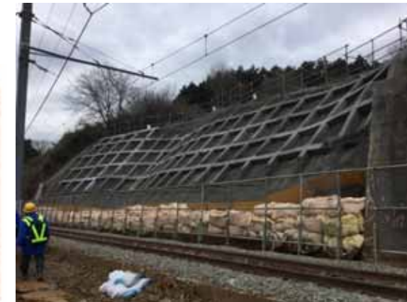
格子砕工施工状況
