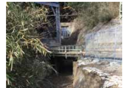
馬込沢しゅん濇完了状況
