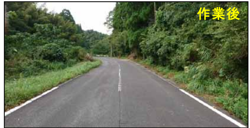
作業状況(県道勝浦上野大多喜線・大多喜町弓木)
