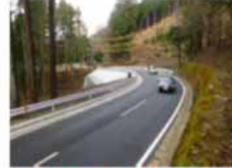
▲完成後(国施工②境沢橋手前)
