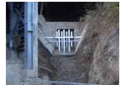
スクリーン復旧状況
