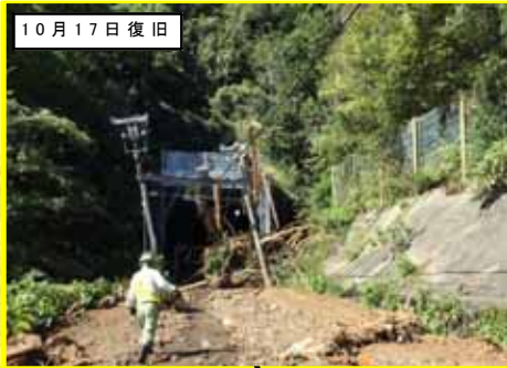
中央本線四方津～梁川間 土砂流入
