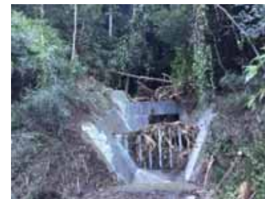
スクリーン堆積状況
