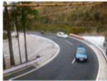
▲完成後(国施工①津口沢橋手前)
