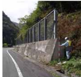
写真：落石防護柵工
