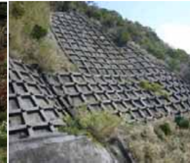
写真：法枠工+アンカー工
