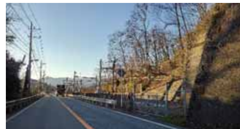
並走する国道20号（梁川駅～烏沢駅）
