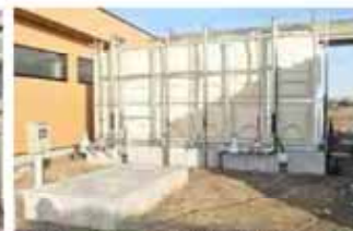
＜道の駅の防災機能強化（貯水タンク整備）＞
