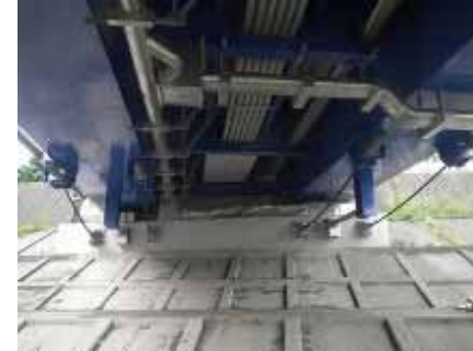
写真：落橋防止システム
