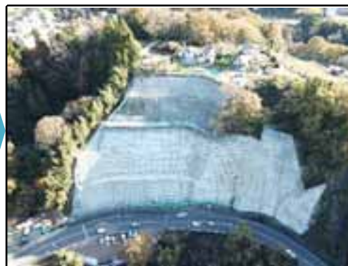
対策後（工事中）
