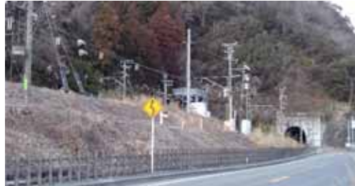
並走する国道20号（梁川駅～四方津駅）
