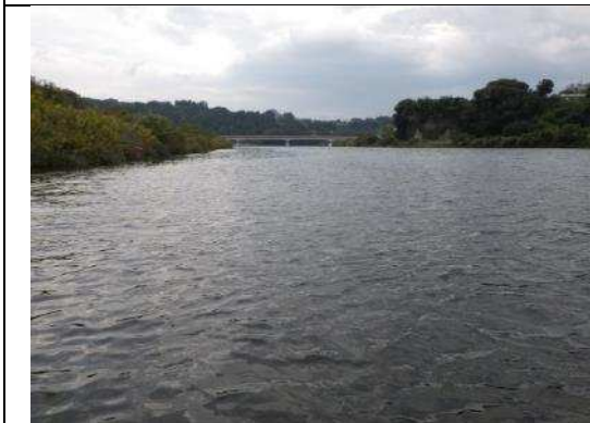
桂川県境部:⑦桂川橋
