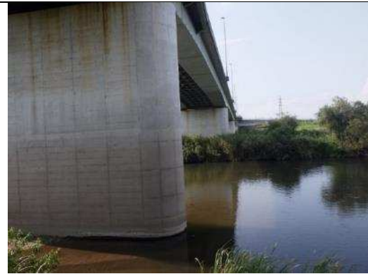
笛吹川下流部:④桃林橋
