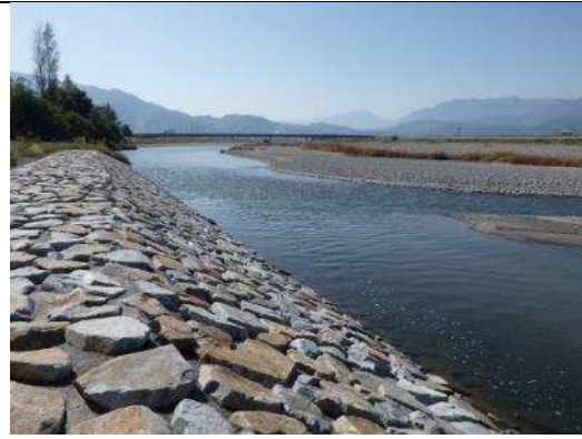
釜無川下流部:②浅原橋
