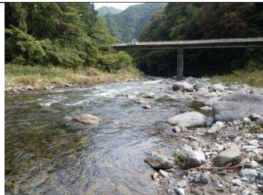
丹波川県境部:⑧下保之瀬橋
