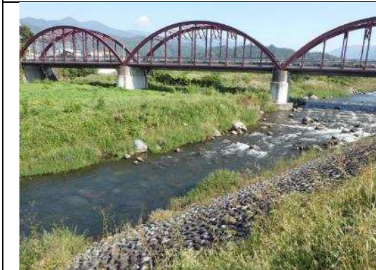
笛吹川上流部:③亀甲橋
