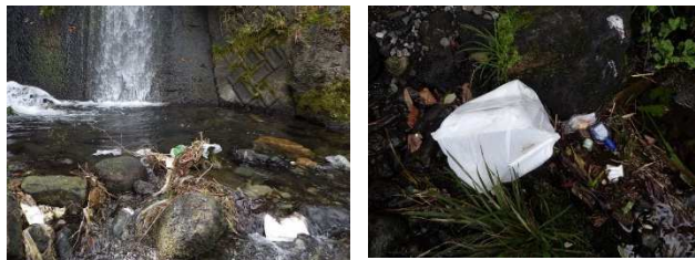
写真 大橋（桂川）
