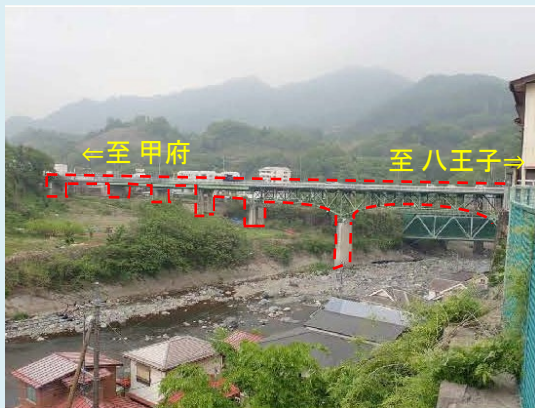
おおつき ① 大月橋 (R7完了予定) 【橋梁補修】 構造物補修、舗装補修等
