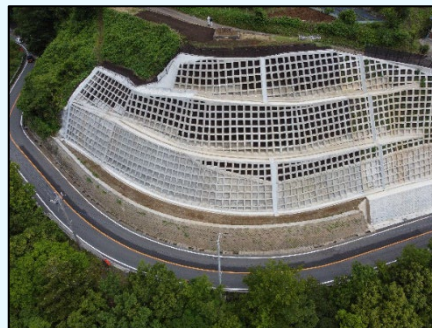
国道413号道路災害防除工事の施工後
