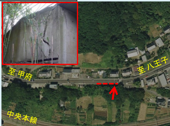
① 山梨県上野原市四方津地先 【防災対策】擁壁工等
