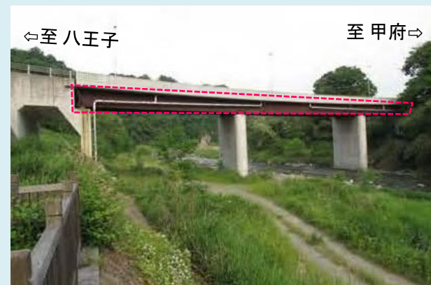
つるかわ ③ 鶴川橋 (R6完了) 【橋梁補修】 構造物補修等
