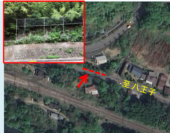
② 【R7補正対策工事】山梨県上野原市四方津地先 【防災対策】既設防護柵の高上げ
