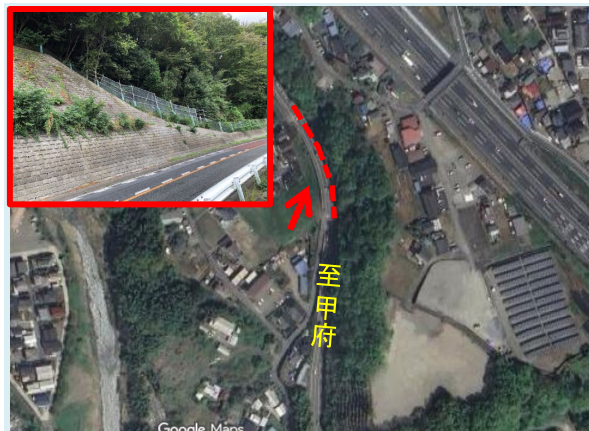
① 【R7補正対策工事】山梨県上野原市上野原地先 【防災対策】既設防護柵の高上げ
