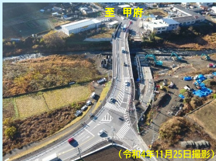
国道20号法雲寺橋新設橋の供用後
