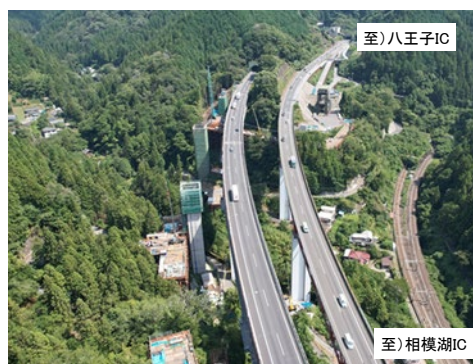
別線橋梁 新設工事実施状況 写真:2025年9月
