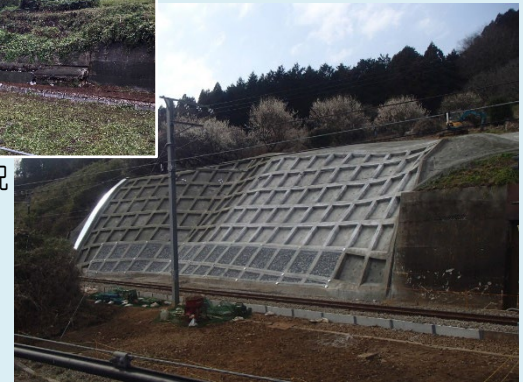
③吹付格子砕工・排水設備整備
