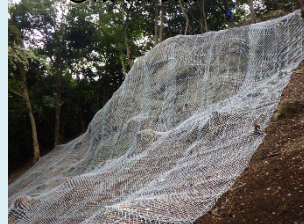
③落石対策工
