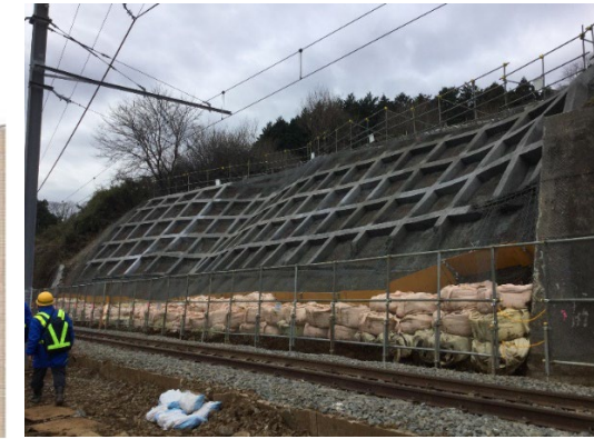
格子砕工施工状況
