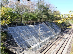
①・②のり面工
