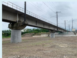
④・⑤耐震補強工
