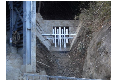
スクリーン復旧状況
