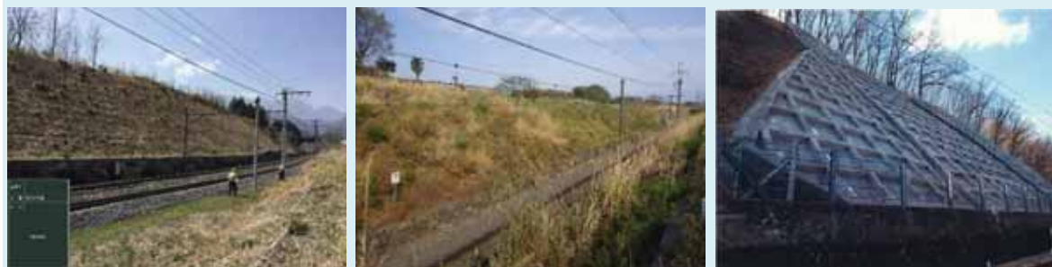
①新府・穴山間(施工前)
