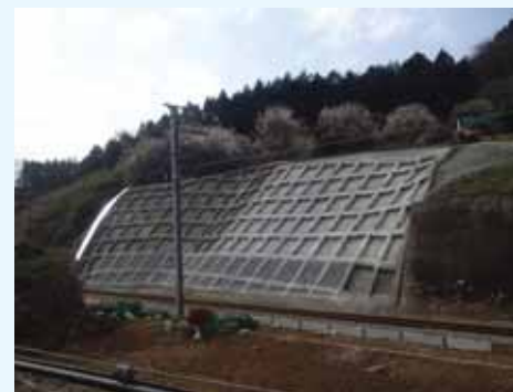
JR中央本線の復旧状況
