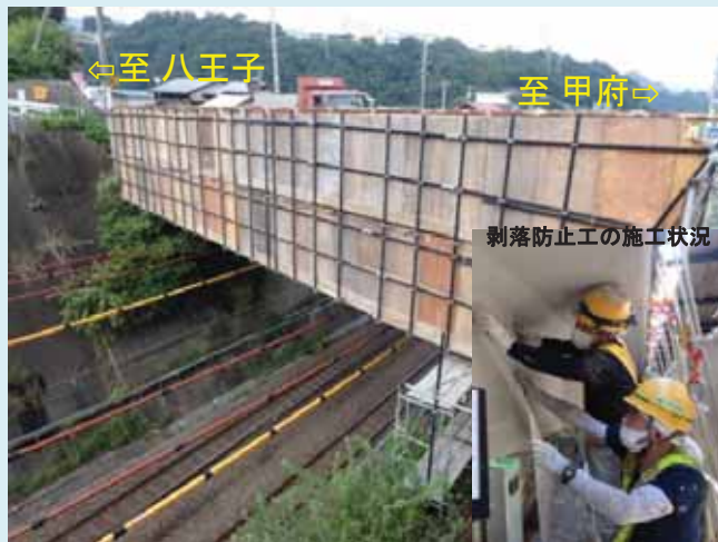
① まつとめ 松留橋 ② まつとめ 松留橋側歩道橋 【橋梁補修】主桁補修、伸縮装置補修等
