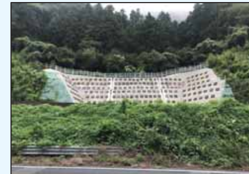
中央自動車道 小仏地区の復旧状況
