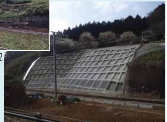
③吹付格子砕工・排水設備整備
