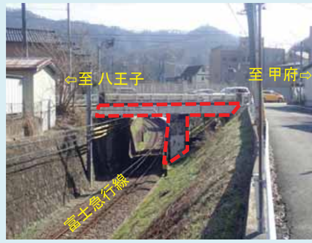
③ てんのう 天王橋 【橋梁補修】主桁補修、橋脚補修等
