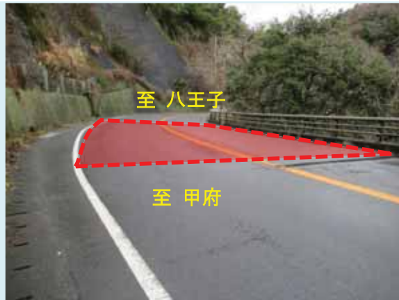
① だいいちどう 【橋梁補修】主桁補修、支承補修等
