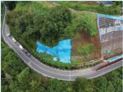
国道413号 対策前
