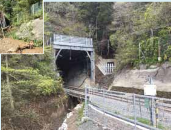
①しゅん濇・土砂止めスクリーン復旧
