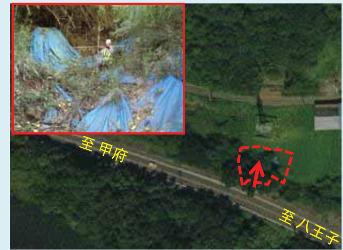
③ 山梨県上野原市松留地先 【防災対策】吹付法枠工等
