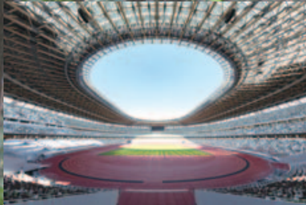
県産カラマツ材をスタンド観客席を覆う大屋根に使用 国立競技場（大成建設株式会社 提供）
