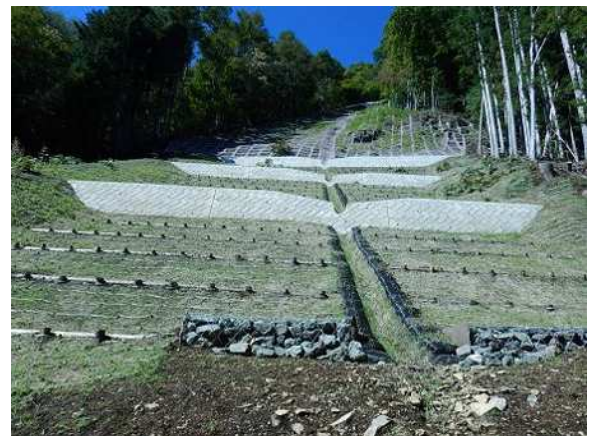
山腹崩壊の復旧
