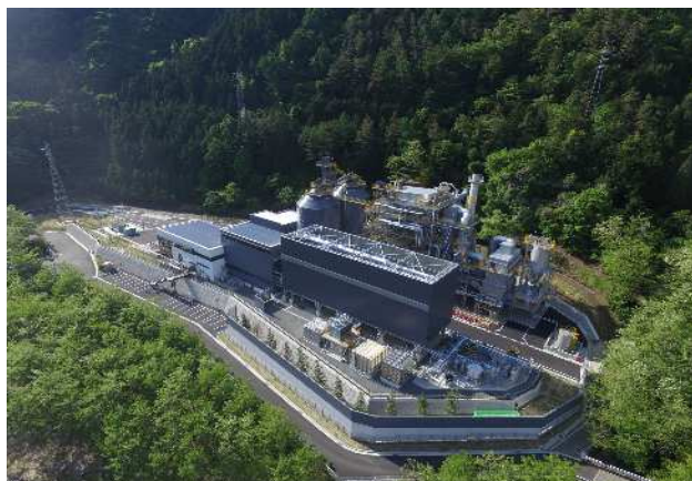
大月バイオマス発電所
