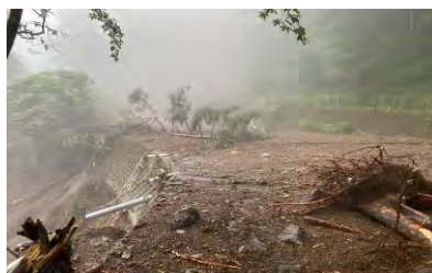
豪雨による土砂崩落 (主要地方道 北杜富士見線)
