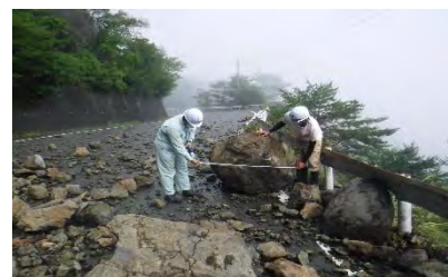
豪雨による落石 (国道 300号)
