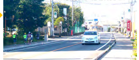
国道411号・勝沼拡幅 改良後
