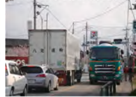
国道411号・勝沼拡幅 改良前
