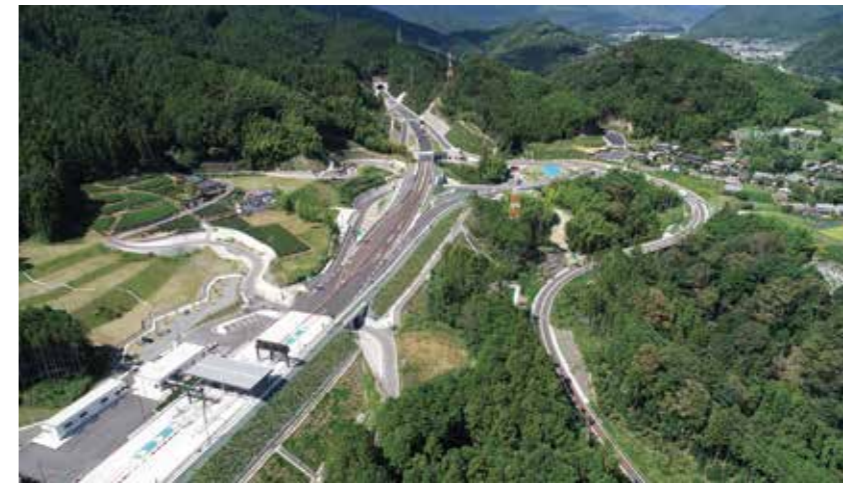
令和元年11月17日に開通した富沢IC～南部IC
