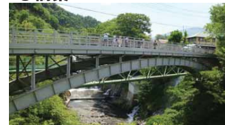
・ 近代土木遺産である佐伯橋の改修デザイン
