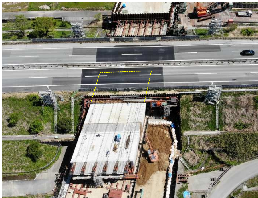
現場全景（南側上空から撮影）
