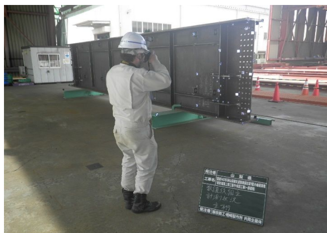
鋼桁寸法社内検査状況(数値仮組立)
