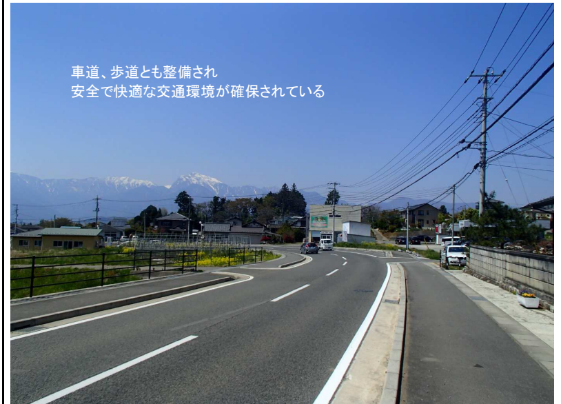
【写真② 整備済み区間の状況】
