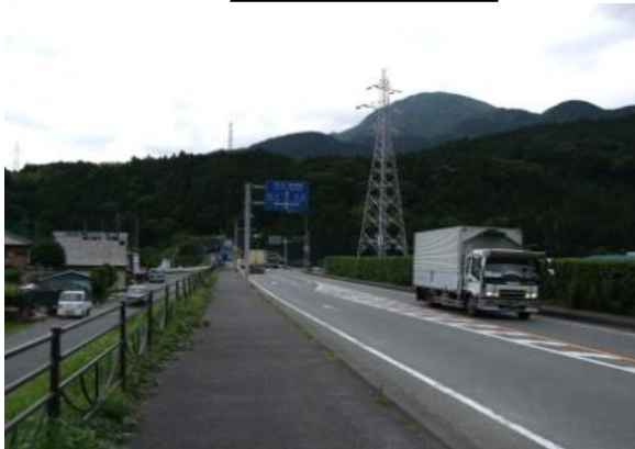
国道52号 (第1次緊急輸送道路)
