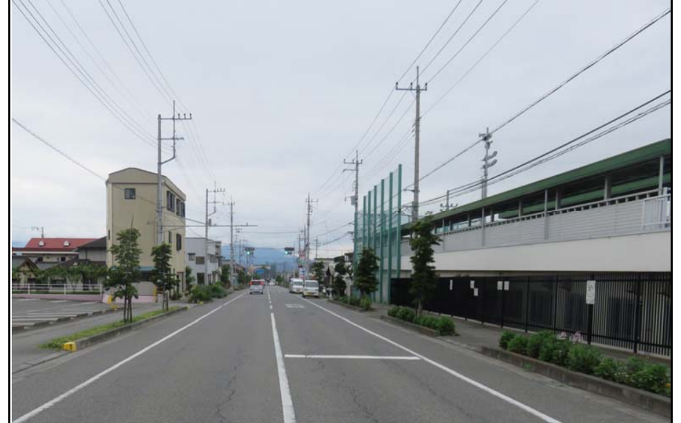
【写真②】 電線、電柱の状況
