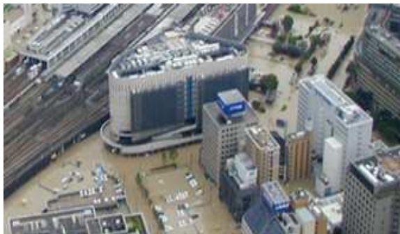
浸水の状況（H15 博多駅）
